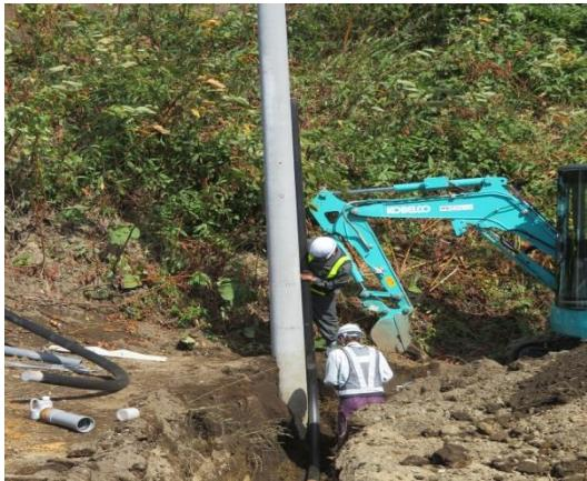
土砂崩れエリアでの電柱建柱作業
