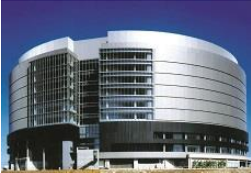
電力広域的運営推進機関が入る建物 (日本ファブテック株式会社HP)
