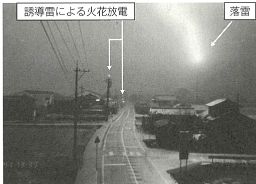
誘導雷により配電線に火花放電が発生した例
