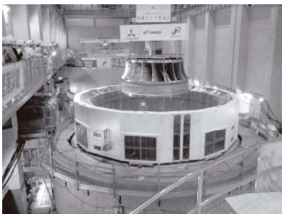
図4 水車据付(電源開発樹田子倉発電所)
