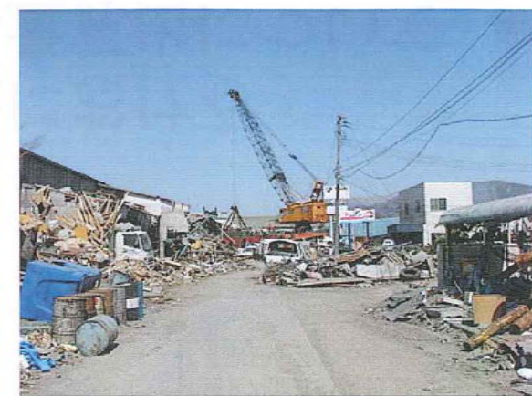
【(岩手県大船渡市)瓦礫撤去の様子】
