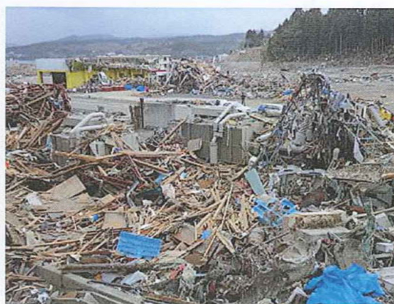
【(宮城県南三陸町) 変電所大規模損壊】
