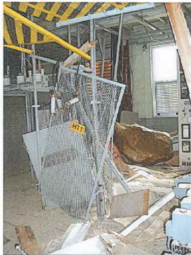
【(福島県福島市) 落石による建物損壊】
