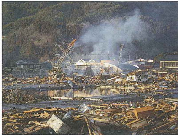
【(岩手県大槌町)6万V送電線 鉄塔倒壊】
