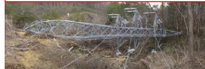
鉄塔の倒壊 (視点②)
