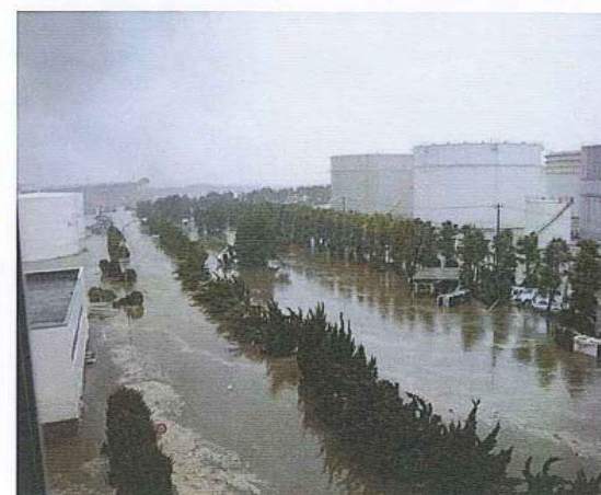
【(火力発電所)津波発生直後《構内西側》】
