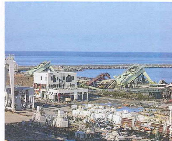
【(火力発電所)倒壊した揚炭機】
