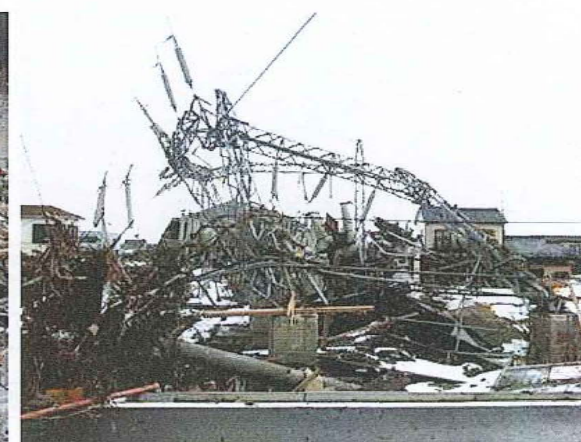
【(宮城県石巻市) 変電所大規模損壊】
