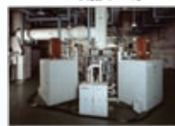
92kV-25kV直流電流遮断器
