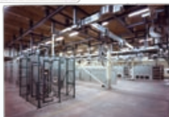
サイリスタ変換器群と直流フィーダー、直流変流器
