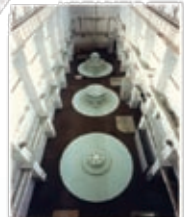
3台の電動発電機 BGJ、最大110万kW
