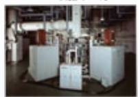
92kA-25kV直流電流遮断器
