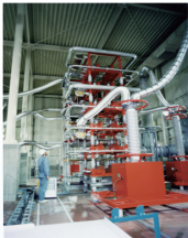
500kV-10MW負イオン中性粒子入射加熱装置用電源
