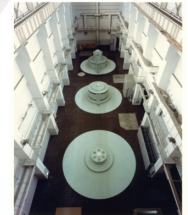
3台の電動発電機 8GJ、最大110万kW
