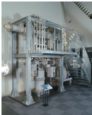
東京電力西堀変電所(埼玉県)72kVガス絶縁開閉装置(1969年、東芝製)
