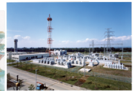
中央変電所 275kV
