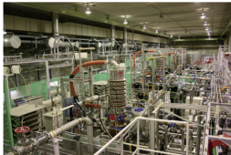
110GHz-4MW高周波加熱装置
