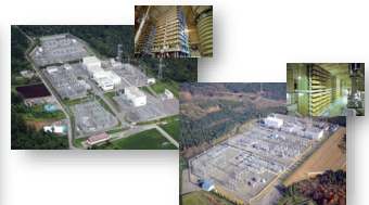
北海道・本州間電力連系設備 モノ ~日本初の本格直流送電設備~ こと Hokkaido-Honshu HVDC Link : Japan's First High Voltage DC Transmission System
