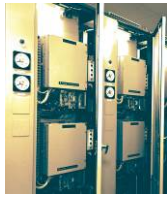
製鉄プラントに適用した安川電機製インバータ (左) と 11 kW～120 kW 誘導電動機 (右)
