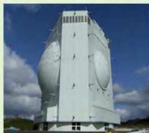
固定式警戒管制レーダー装置
