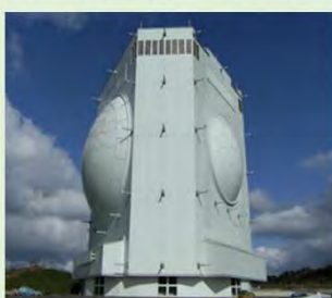
固定式警戒管制レーダー装置
