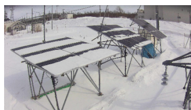
図1 発電量(積雪時)データ測定設備
