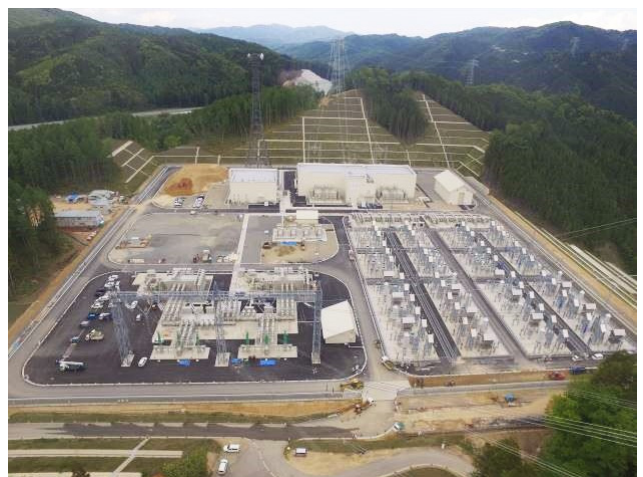
図2 現在の飛驒変換所(2020年6月)
