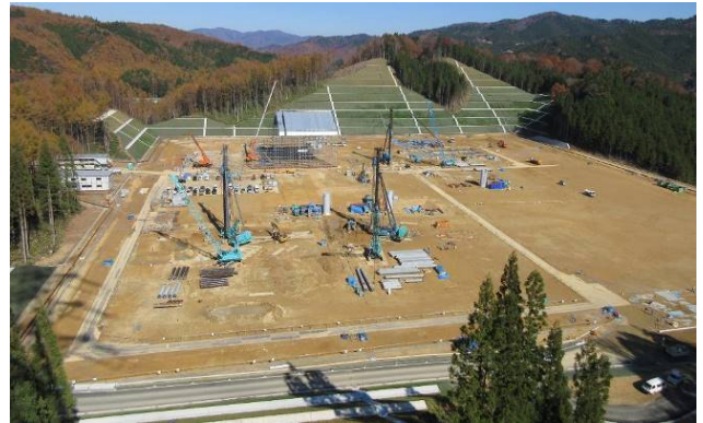
図1 造成工事完了後の飛驒変換所(2017年11月)
