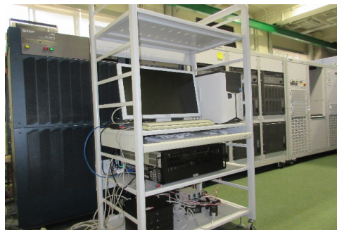
図1 模擬配電系統設備
