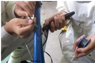
写真3 配線取り付け作業(半田付け)
