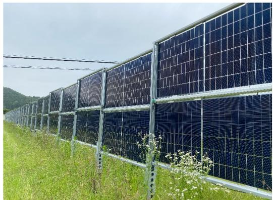
図2 垂直設置型 PV システム (ゴチカン)
