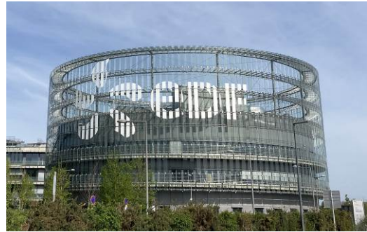
図1 EDF R&D の建物の外観
