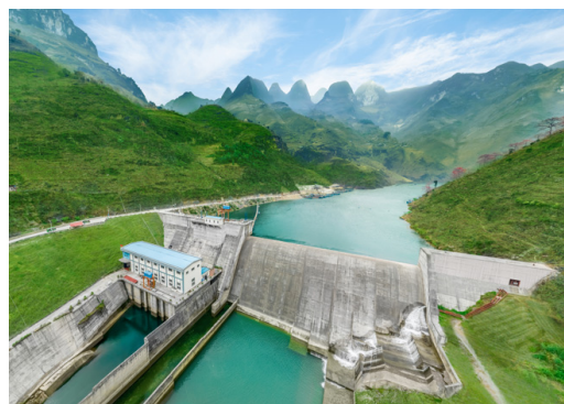
図 1 Nho Que 1 発電所
