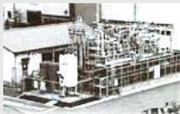
リン酸型50kW試験プラント
