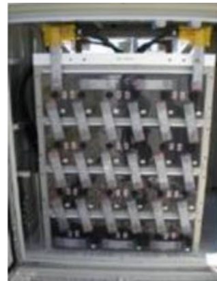
図26 バッテリーによる電力供給
