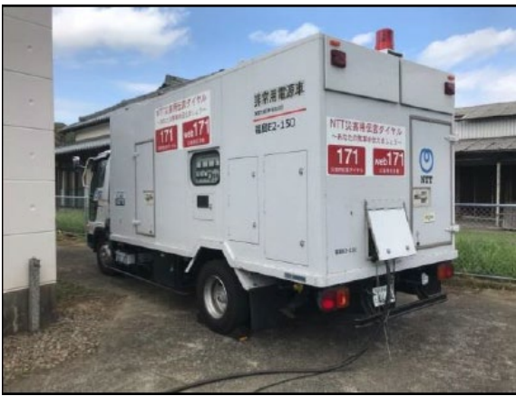
図 23 移動電源車による電力供給
