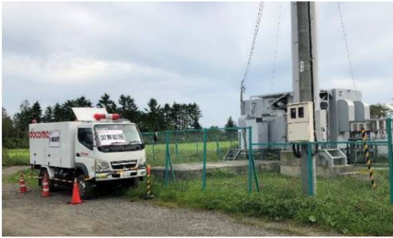
図 27 移動電源車による電力供給
