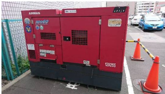
図 28 非常用電源による電力供給
