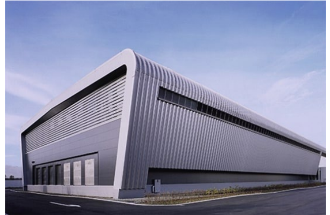
図 32 石狩データセンターの外観
