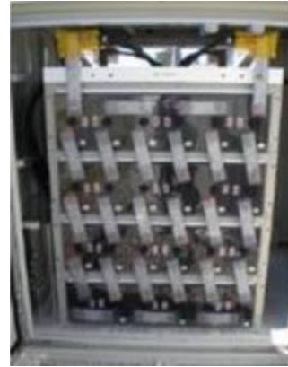
図26 バッテリーによる電力供給
