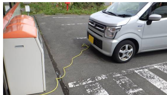
図45 非常用電源キットの接続状況
