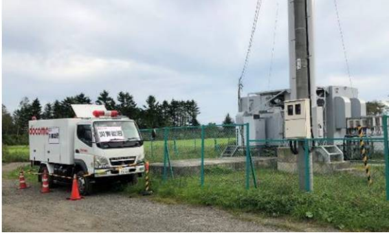
図 27 移動電源車による電力供給
